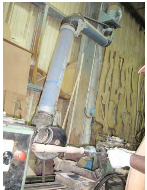
Système d'aspiration à la source des poussières de bois
