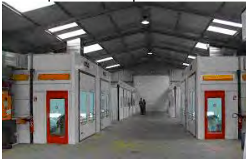
Les cabines de peinture avec étuve
