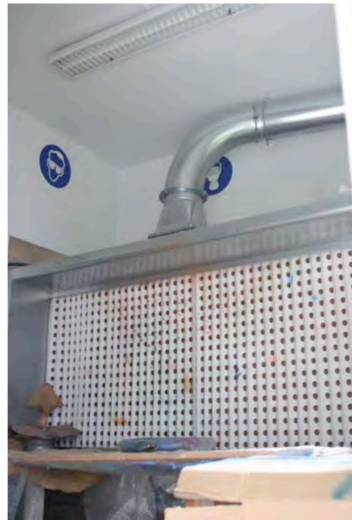
La cabine de ventilation, située au niveau du poste de travail
